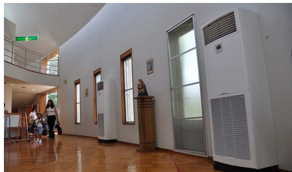
<幼稚園> ホールエアコン設置
