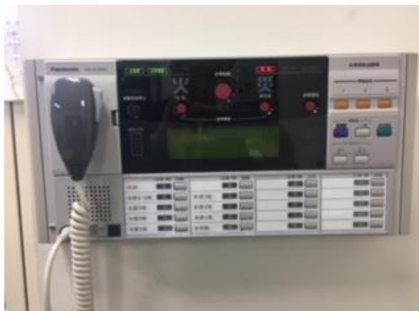
<非常放送設備>
